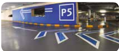
Wykonanie oznakowania na posadzce
